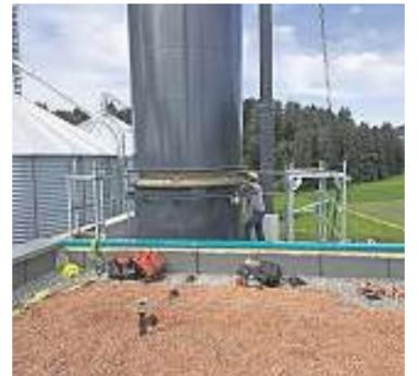
Nach dem gelungenen Transport wurden die zwei Kaminteile mit einem Pneukran montiert und die zwei vorgefertigten Rohre aufgesetzt.
